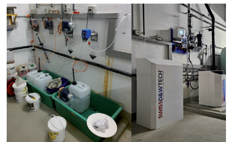
Dosierstation vorher und nachher (rechts).
